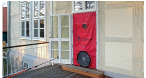
BlowerDoor Messung im Rahmen einer energetischen Sanierung
