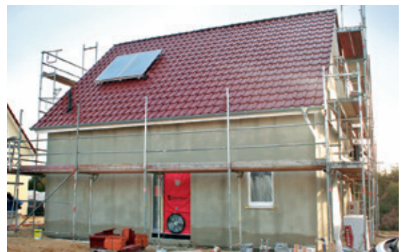
BlowerDoor Messung eines neu gebauten Einfamilienhauses
