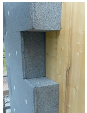
Abb. 7: Eine ungewöhnliche Kombination von Massivholzbau und fossilem Dämmstoff. Aber die energetische Gesamtbilanz ist bedenkenswert (Tab. 3, Zeile 7). Foto: Gerrit Horn
